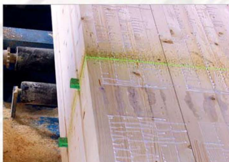
カット位置を示すレーザーマーキング
