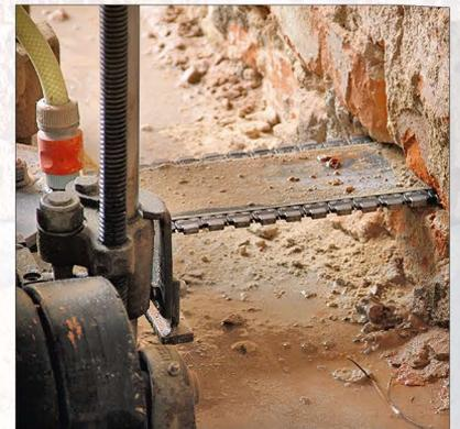
2. Abschnittweises Durchtrennen des Mauerwerks mit der PRINZ-Kettensäge PMS 25, EED oder ESL 30 bei Ziegelmauerwerk bzw. mit der PRINZ-Diamant-Seilsäge LP1 bei Bruchstein- oder Mischmauerwerk.
