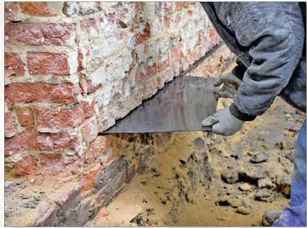
Anschließendes Verkeilen der Schnittfuge mit statisch belastbaren Kunststoff-Ankerplatten im Abstand von maximal 25 cm über den gesamten Mauerquerschnitt (Belastbarkeit mindestens 500 kp/cm<sup>2</sup>).
